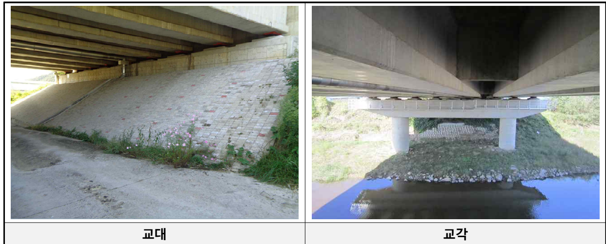
[교대 및 교각 전경]
