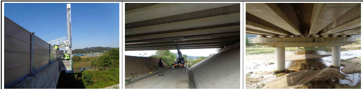
[고소작업차, 굴절점검차를 이용한 근접조사 실시]
