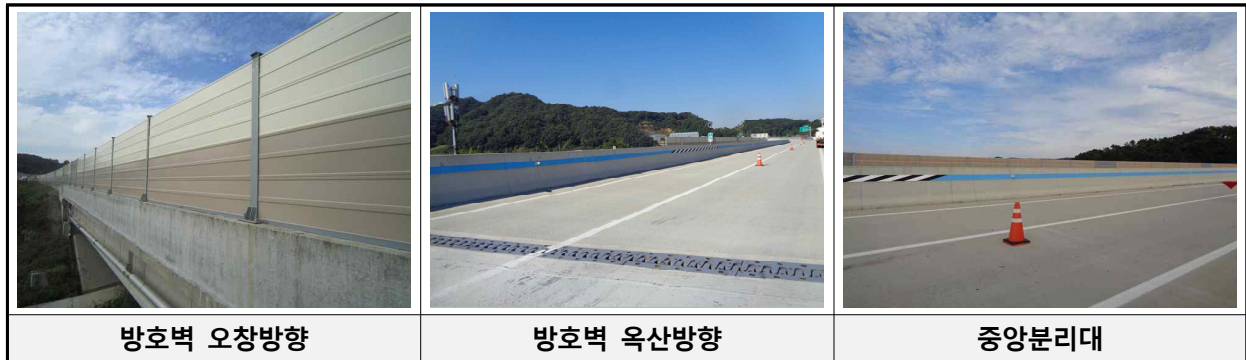
[방호벽 및 방음벽 전경]
